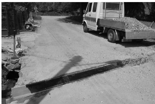
Zastów - prace przy odprowadzeniu wody z drogi gminnej
